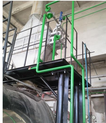
Fig.5 Vedere generala a cazarului 6t/h 12 bar cu Instalatia de Recuperare montata.
