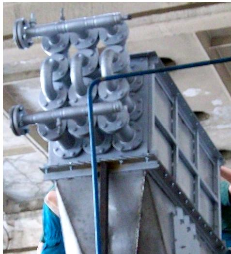
Fig. 1 Recuperator caldura din gazele arse cu PSEUDO TUB TERMIC
